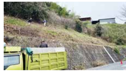
北側法面の防草処理が始まりました
